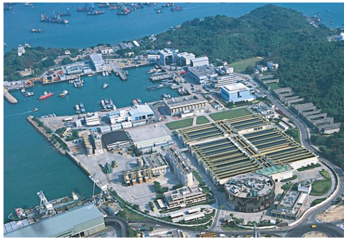
昂船洲污水處理廠
